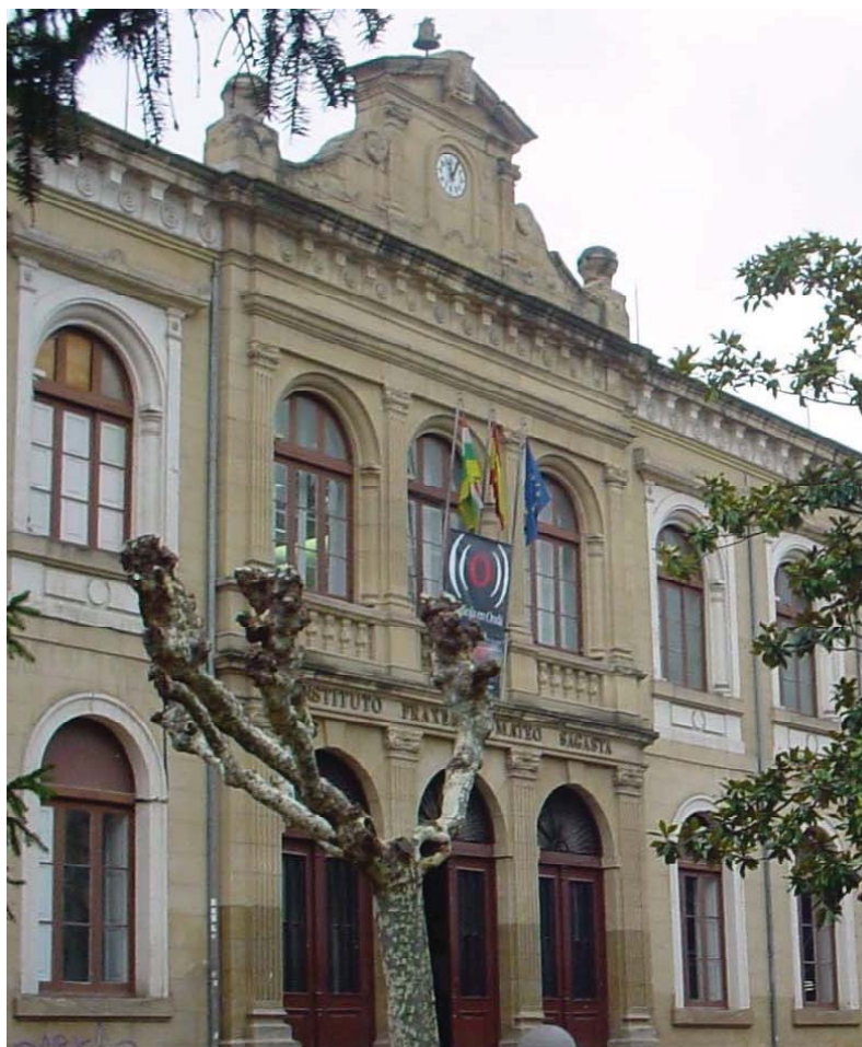
Foto 1. Fachada del edificio.
